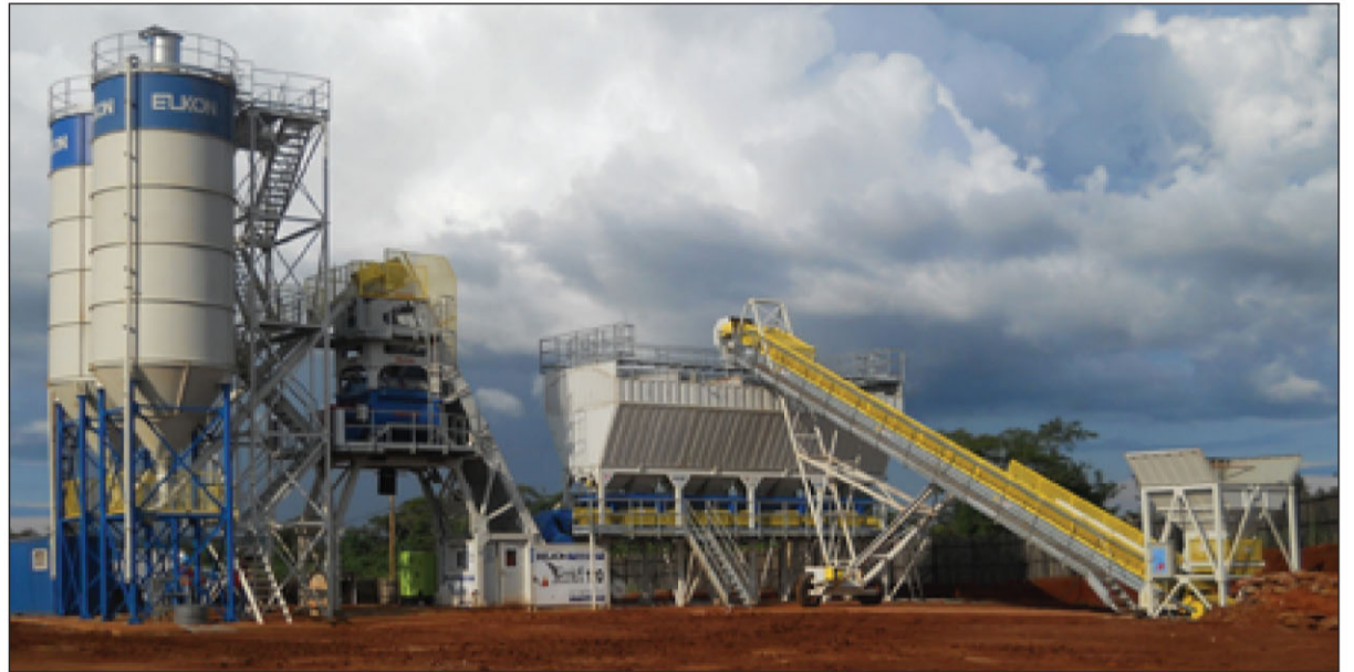
Стационарный быстромонтируемый завод ELKOMIX 120 QM для компании Лафарж (Франция). Изготовлено в соответствии с требованиями Евросоюза к безопасности и обслуживанию БСУ.
